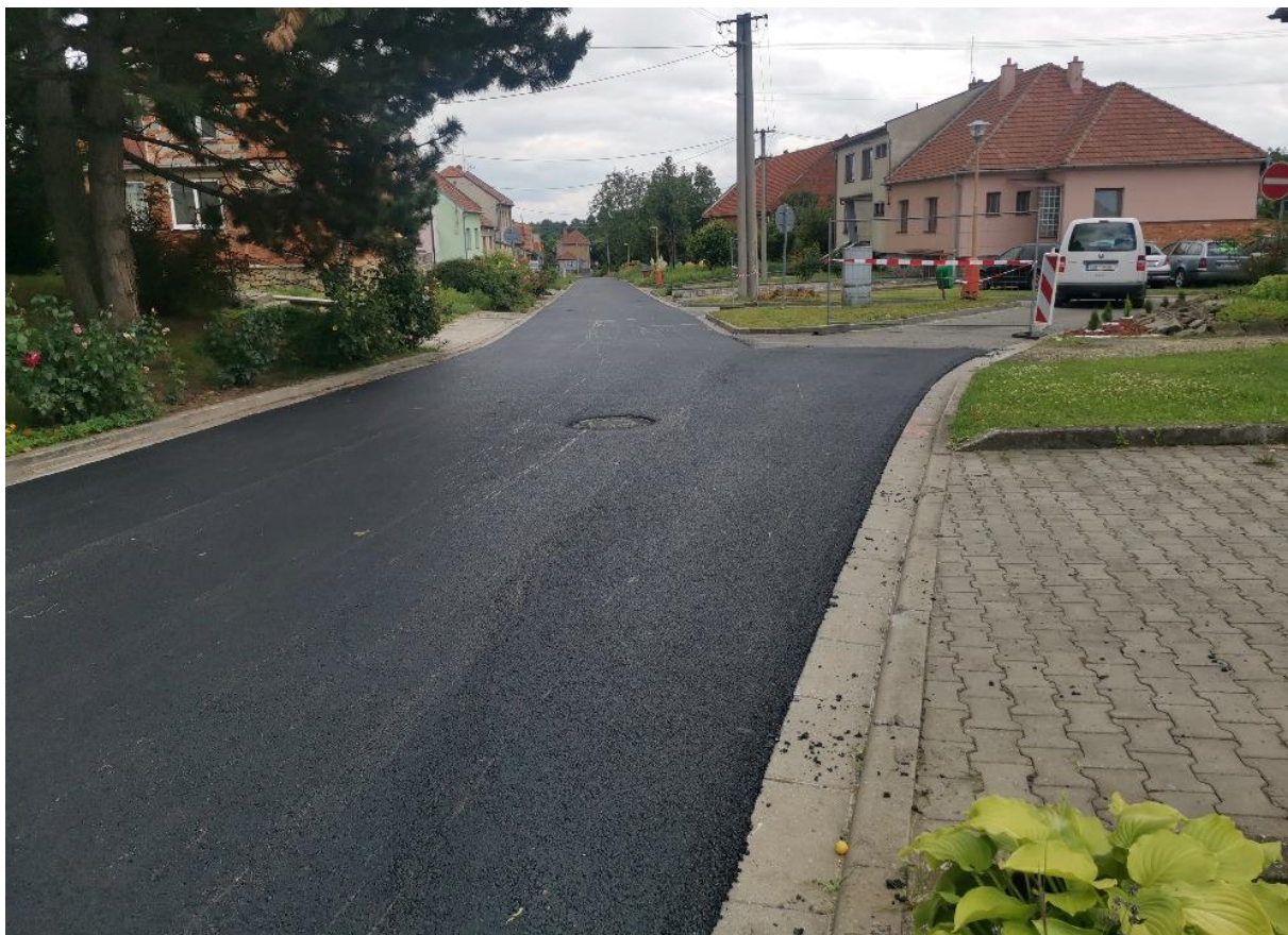
Obrázek 4: Ukázka stavu místních komunikací po rekonstrukci
